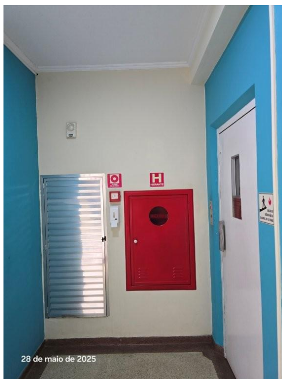
Foto 10 – Vista geral do hall do elevador do imóvel
