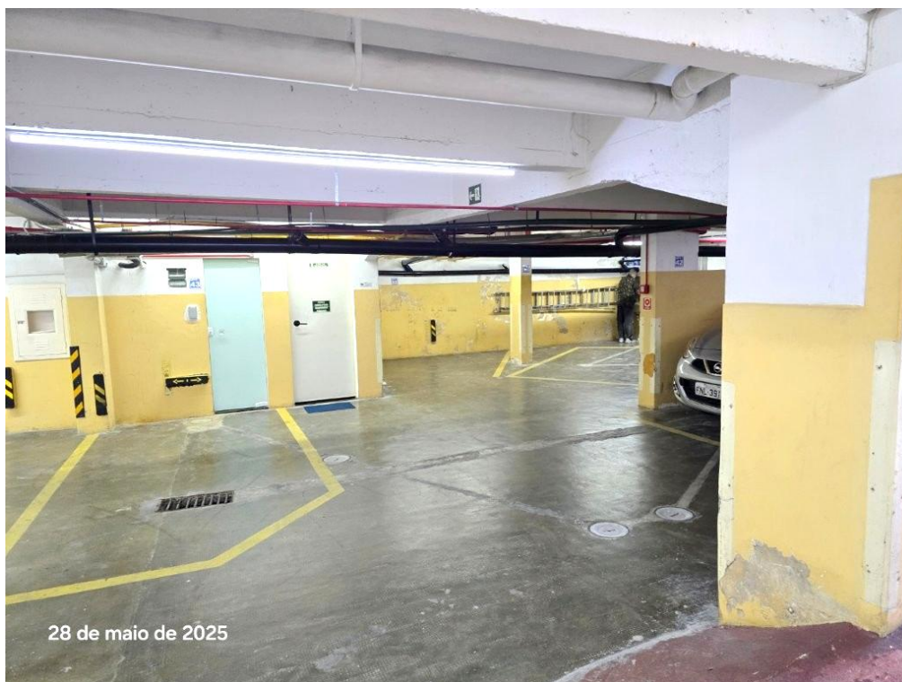
Foto 27 – Outra vista geral da garagem - Subsolo
