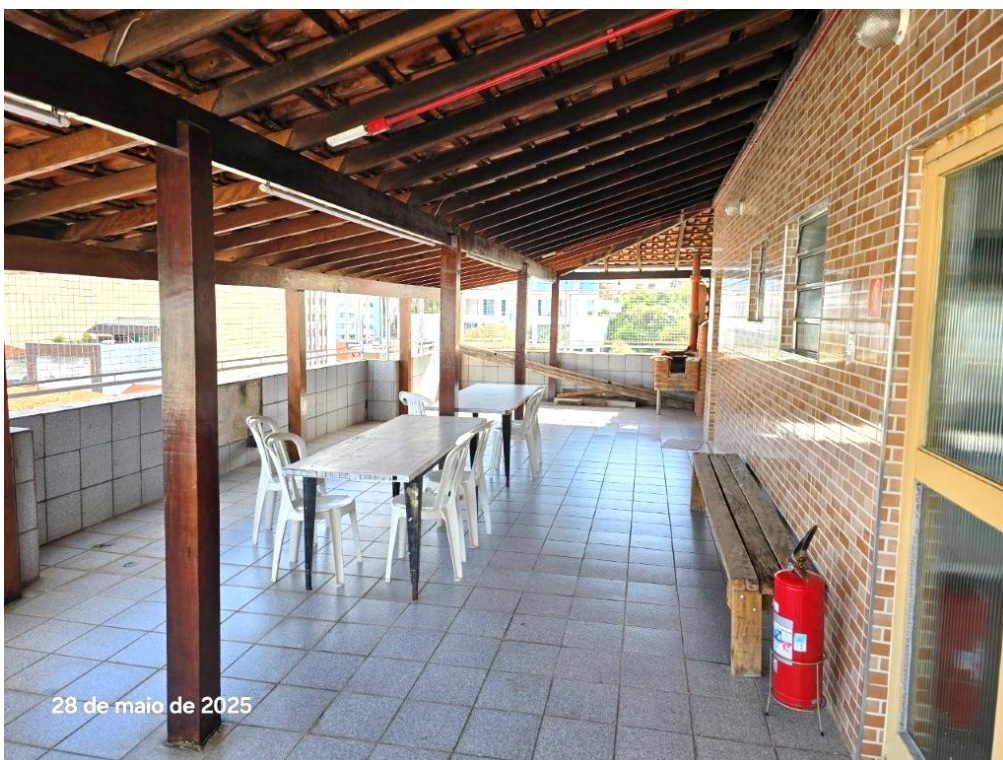
Foto 23 – Vista geral do salão de festas - cobertura
