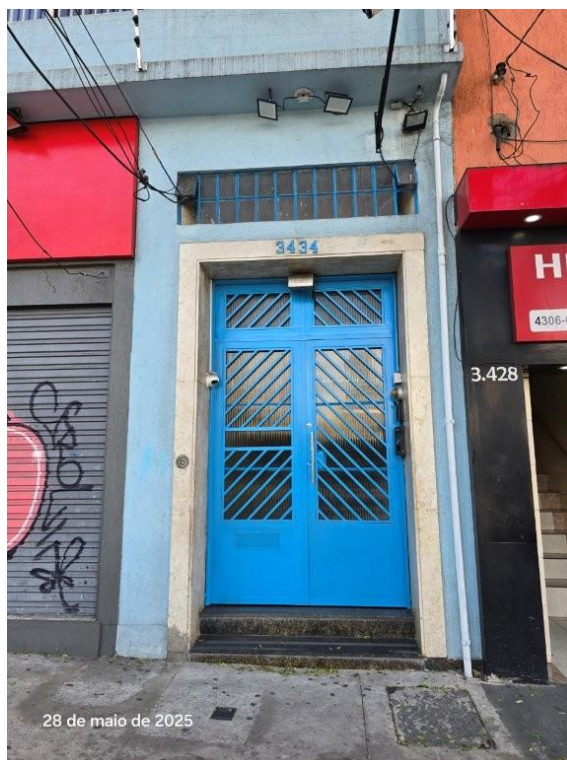
Foto 03 – Vista geral do acesso de pedestres ao imóvel – Cond. Ed. Cruzeiro do Sul
