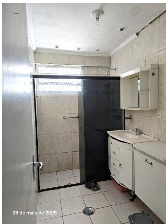
Foto 20 – Vista geral do sanitário
